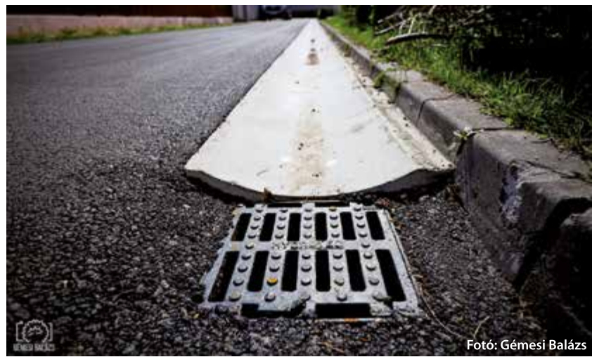
A Suba-öböl terület rész védelmét szolgáló vízvezető-hálózatfejlesztése 12 utcát érintett
